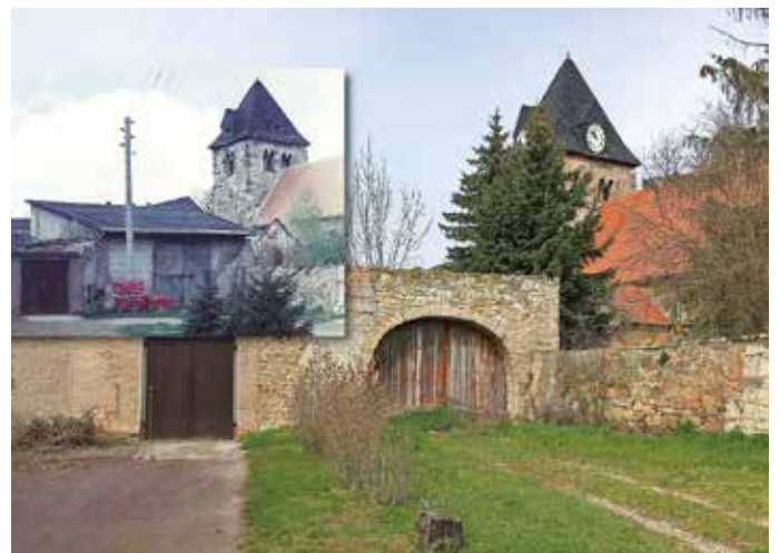
Der Kirchblick mit der wiederhergestellten Toreinfahrt
