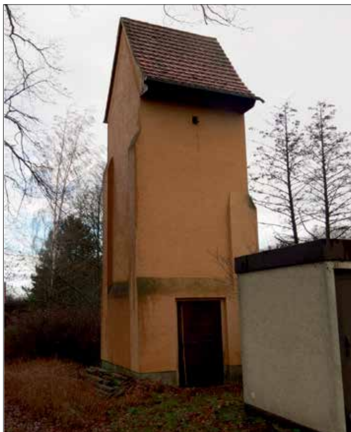
Trafoturm Wils vor der Umgestaltung zur „Stele der Biodiversität“
