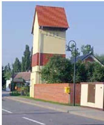
Neu gestaltetes ehemaliges Trafoshaus Foto: E.-M. Krost
