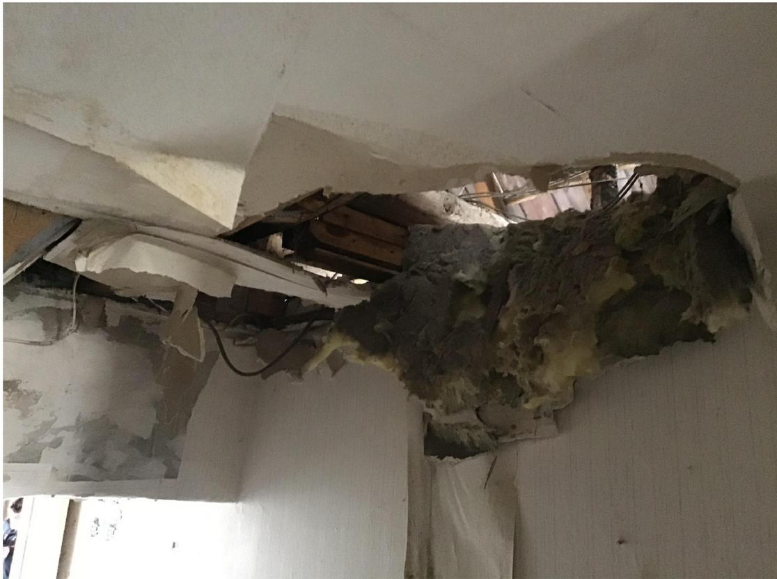
Schäden an der Geschossdecke des Dachgeschosses
