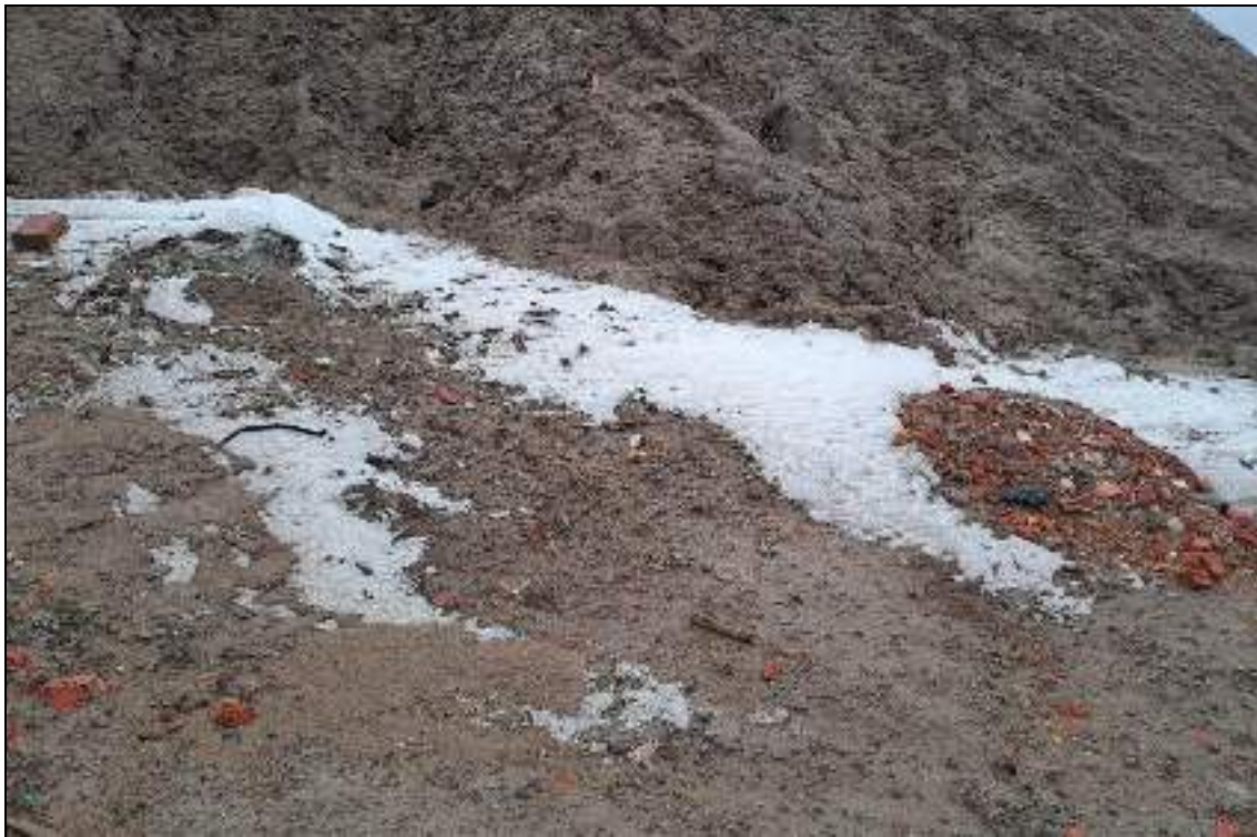
Abbildung 3-10 Salzausfällungen an der Abbauhalde Johannashall
