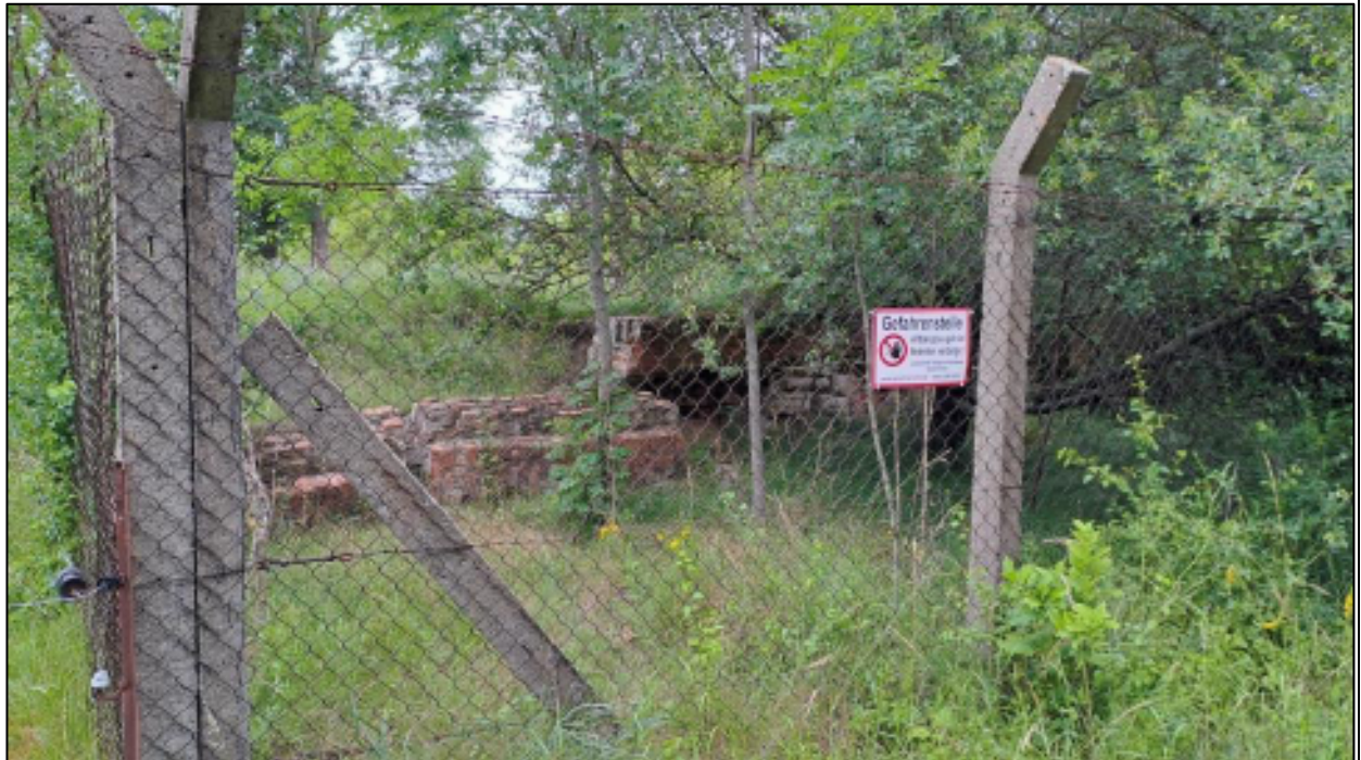
Gebäudereste der historischen Schachtanlage
