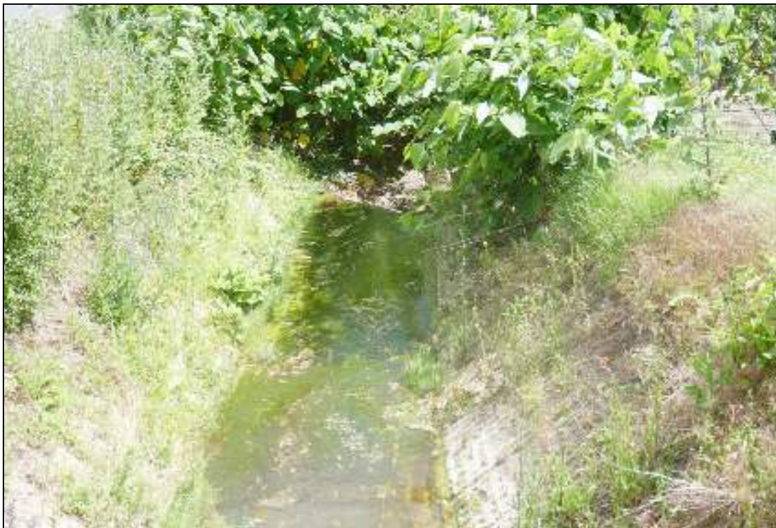
Abbildung 3-26 Naturfernes eingetieftes Gewässerbett mit linearem Verlauf, Befestigung durch Sohlschwelle und Gittersteinpflaster im Uferbereich sowie neophytischer Ufervegetation (Staudenknöterich)
